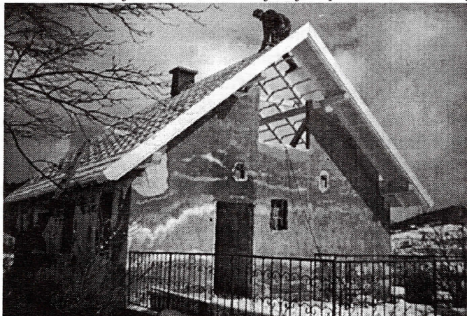
Prva nakon rata obnovljena kuća na općini
